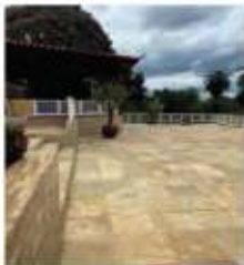
Guarda Corpo Metálico
