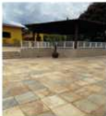
Guarda Corpo Metálico
