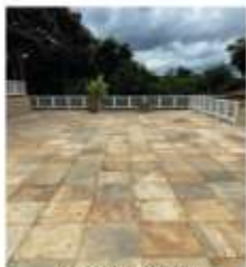
Guarda Corpo Metálico
